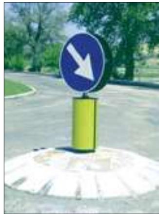
Delineatore di Ostacolo montato doppio installato al centro di una rotonda.
