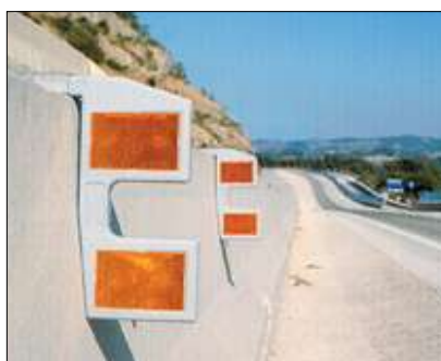
Parte anteriore delineatori su barriera New Jersey con 2 catadiottri 10x15 omologati
