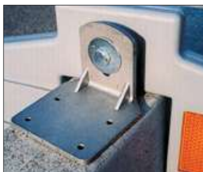
837 Staffa per ancoraggio delineatore stradale tramite staffa su barriera New Jersey
