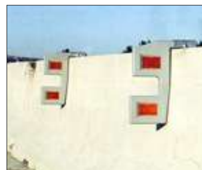
Particolare montaggio delineatore con spinotto ad incastro su New Jersey provvisto di fori
